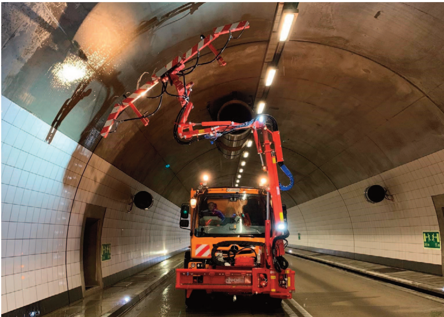
Hochdruckschwemmbalken beim Einsatz im Tunnel
