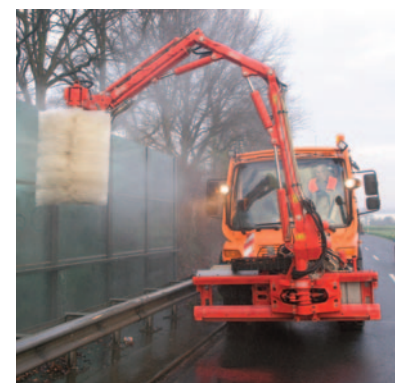
SWA 900 bei der Reinigung von Lärmschutzwänden
