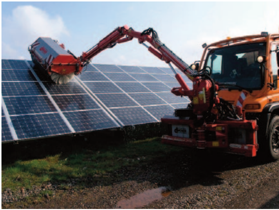
TWA bei der Reinigung von Solarmodulen
