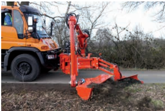
Banketträumschnecke BRS 15 im Einsatz
